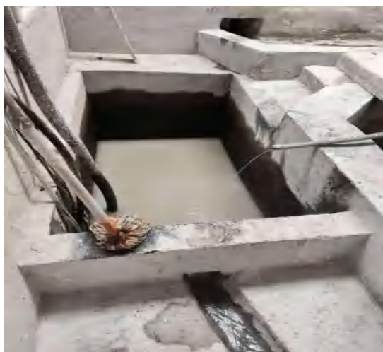
车间内沉淀池
