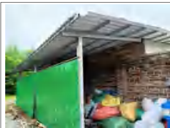
一般固废暂存间
