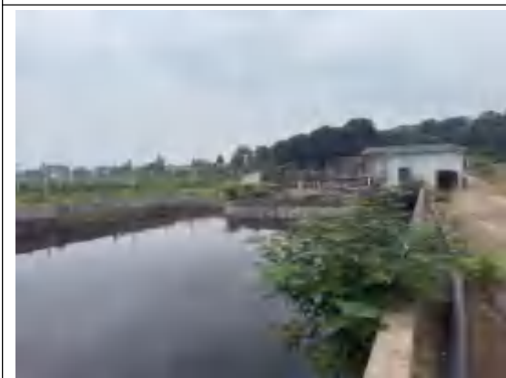
柑橘小镇废水处理设施
